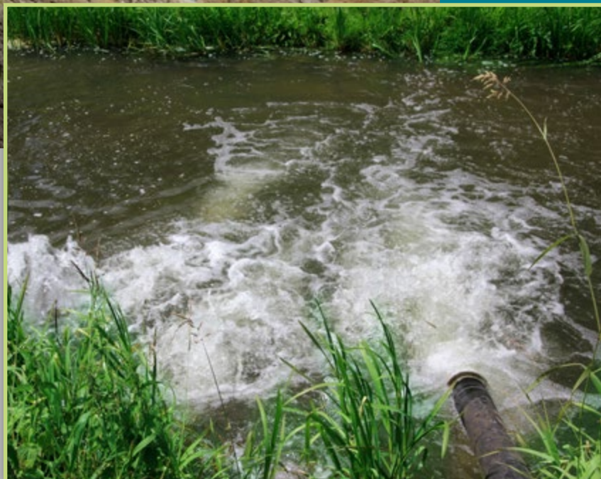
Lozing grondwater op watergang
