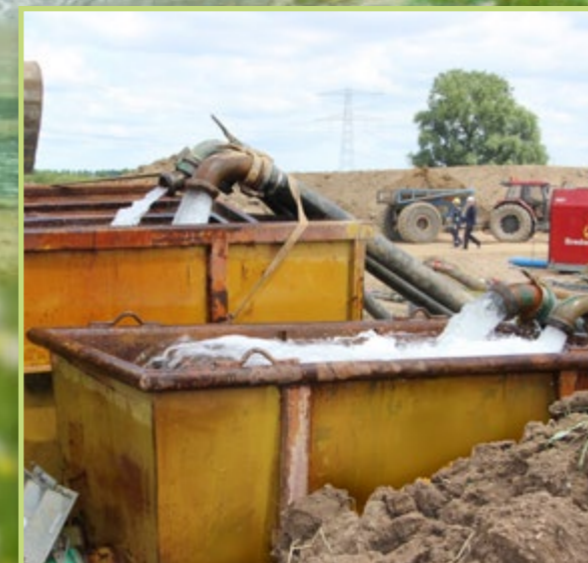
Lozing grondwater via bezinkbak op oppervlaktewater
